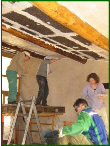
Le chantier participatif pour les enduits du fournil de Charline.
